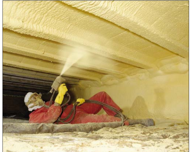
Ruiskutettava PU-eriste liimautuu rakenteisiin muodostaen saumattoman eristeen myös monimuotoisiin rakenteisiin.
