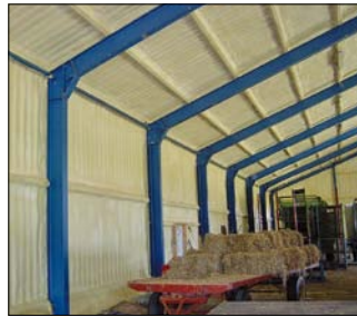
Ruiskutettava PU-eriste liimautuu rakenteisiin muodostaen saumattoman eristeen myös monimuotoisiin rakenteisiin.
